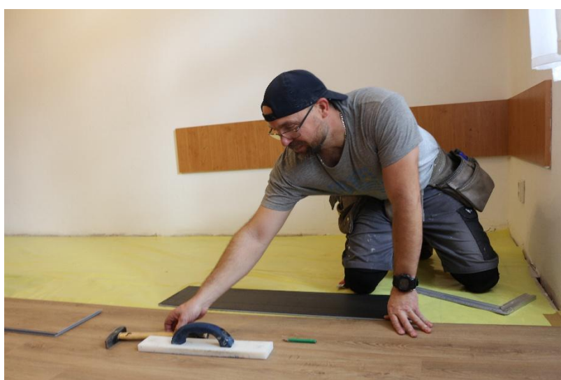
Oprava podlah v lázeňském domě Libuše
